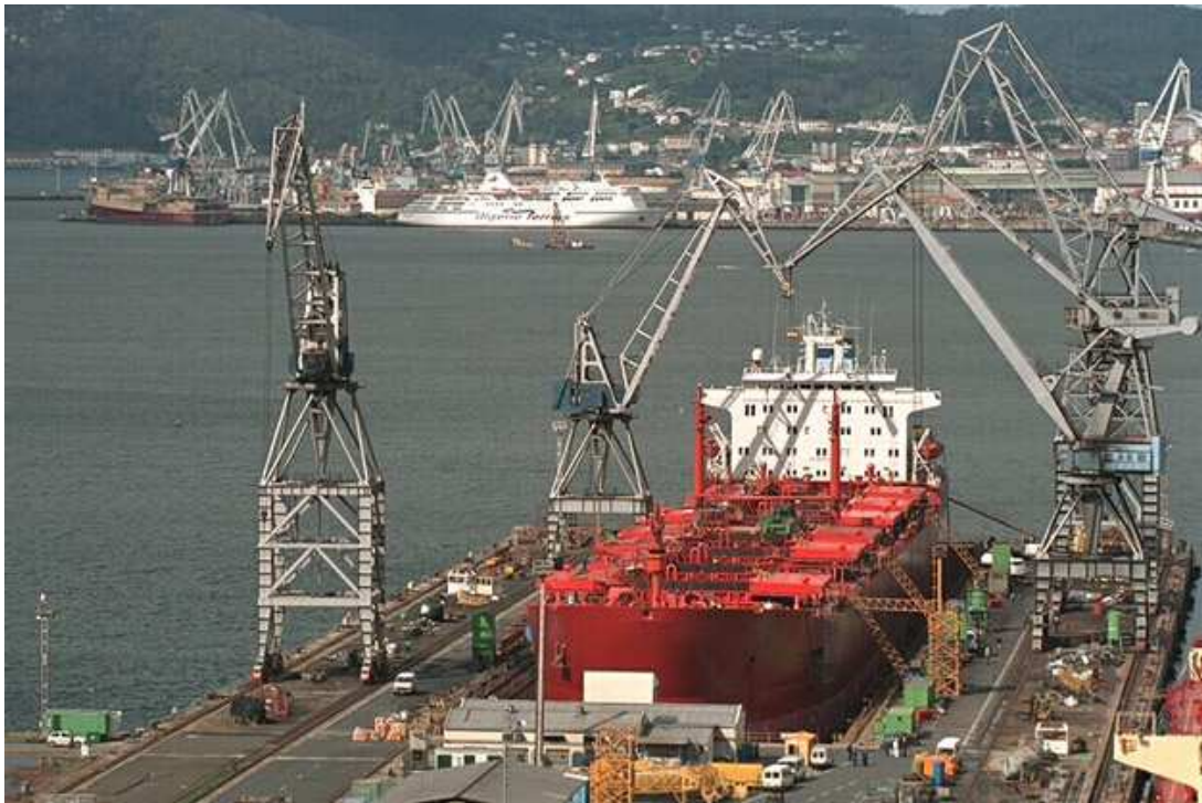
Dique de Reparaciones-Fene (Ferrol)
